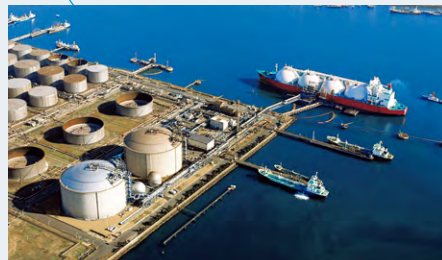
Mizushima LNG Base
