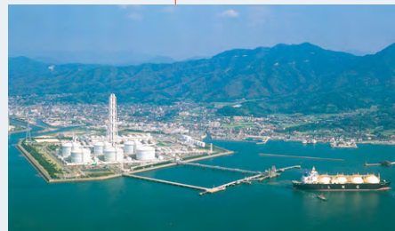
Yanai LNG Base
