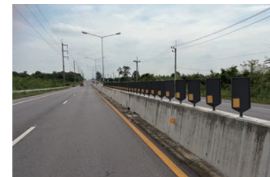
タイの国道での防眩板設置プロジェクト
