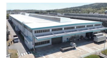
工場の遮熱対策 (屋根および壁面の遮熱塗装)
