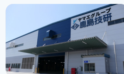
(株)鹿島技研 新本社工場
