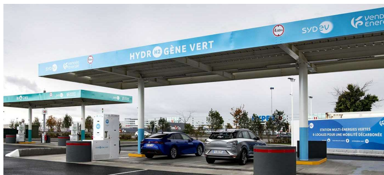
Station hydrogène vert à La Roche-sur-Yon (Vendée) alimentée par l'hydrogène produit par Lhyfe
