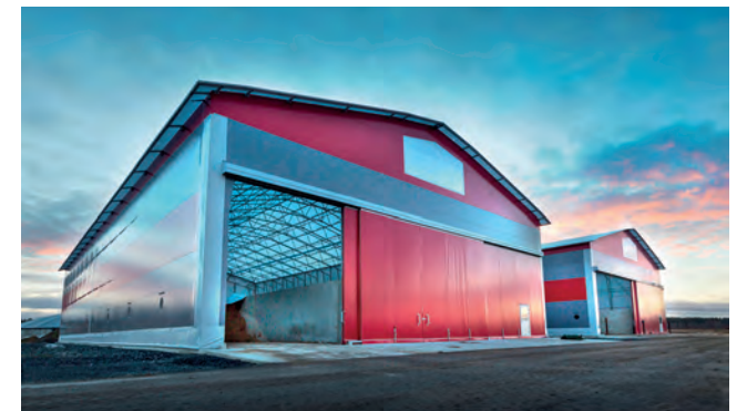
Hangar de stockage ■ Finlande
