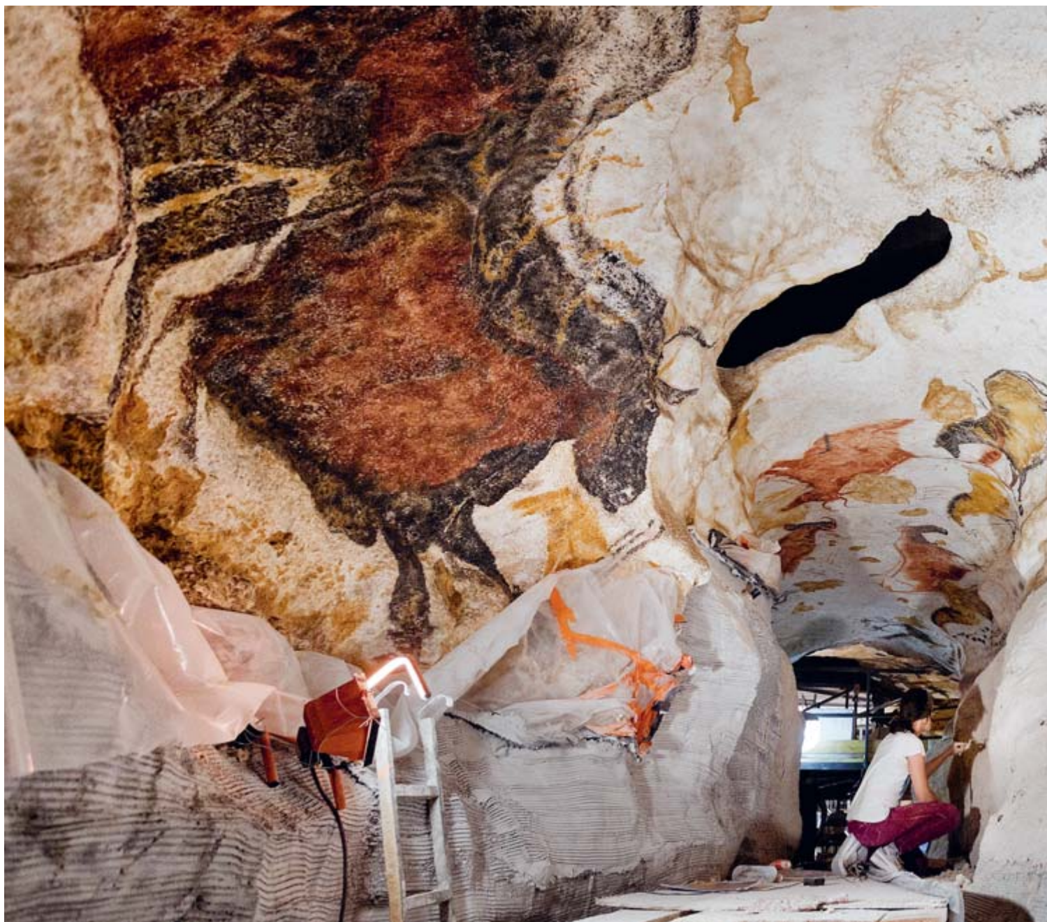
Installation des équipements de climatisation et de traitement d'air à Lascaux IV, fac-similé de la grotte de Lascaux à Montignac (Dordogne)
