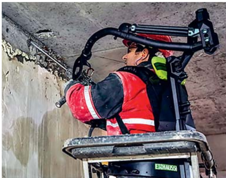
Test d'un exosquelette, destiné à réduire les risques liés au portage d'outils et à faciliter les mouvements, sur le chantier de rénovation d'un hôtel particulier classé, rue de Courcelles, à Paris.
