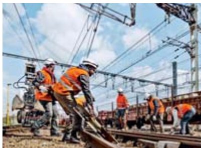
9 Remplacement d'appareils de voies à Brétigny-sur-Orge (Essonne).
