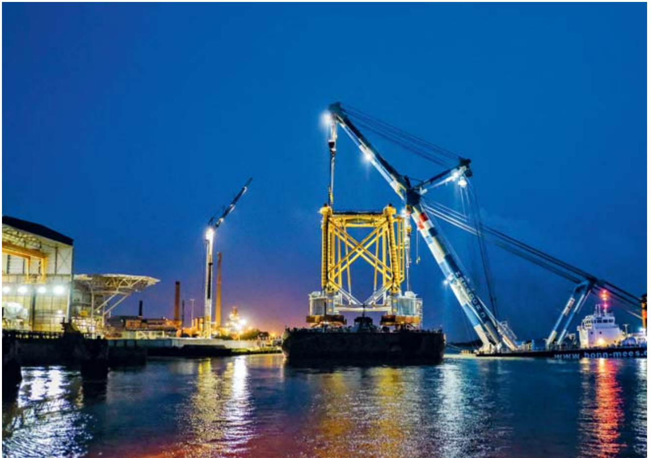
Fondations pour champs éoliens offshore
