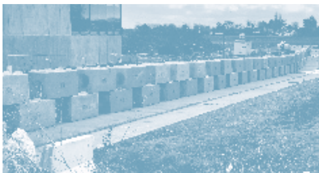
Blocs béton recyclés, les «smart bloc»
